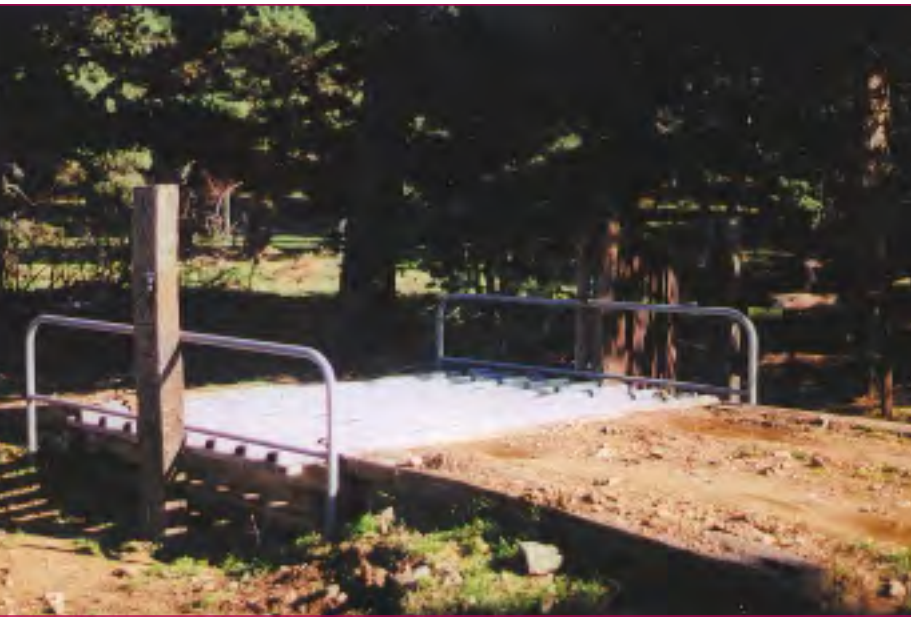
Des aménagements (ici passage canadien) doivent être mis en place dans le cadre d'un sylvo-pastoralisme bien pensé.
